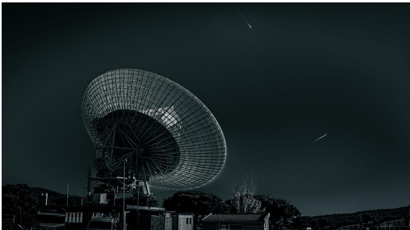
La antena de la foto, tiene un diámetro de 70m una potencia de transmisión de 20Kw, un peso de 8500Tm, superficie de 4180 m<sup>2</sup>, y velocidad de 0.25 grados/s. Esta foto ha sido finalista del Concurso Ciencia Jot Down.
