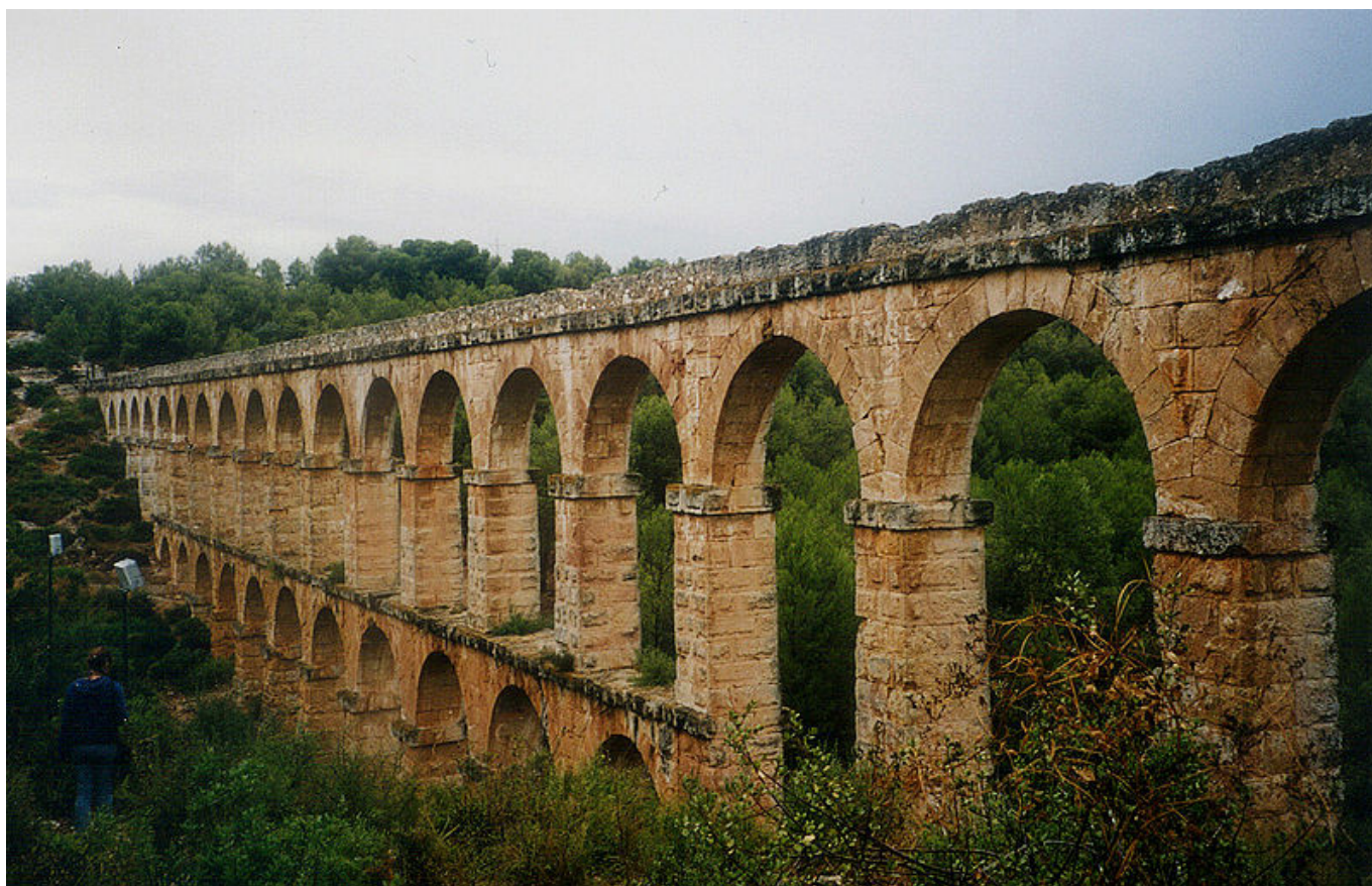
Acueducto de Tarragona
